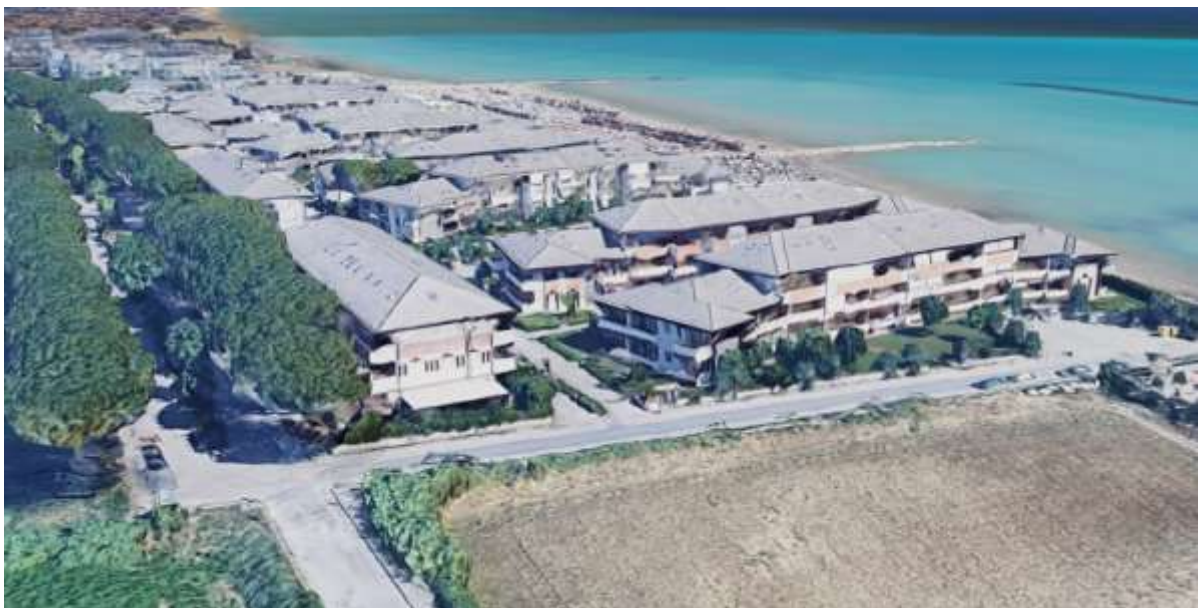
Assetto urbano esistente lungo Vicolo Volturno
