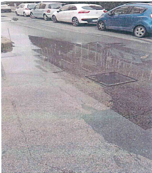
Perdita idrica Via Tordino – localizzazione punto di intervento
